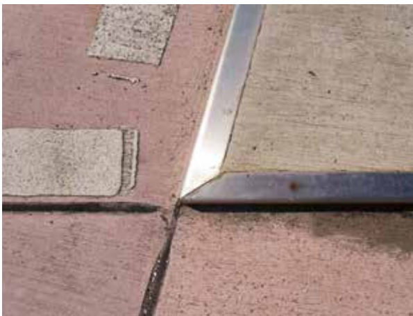
Abb. 11 Detail Fahrbahnteiler mit Stahleinfassung
