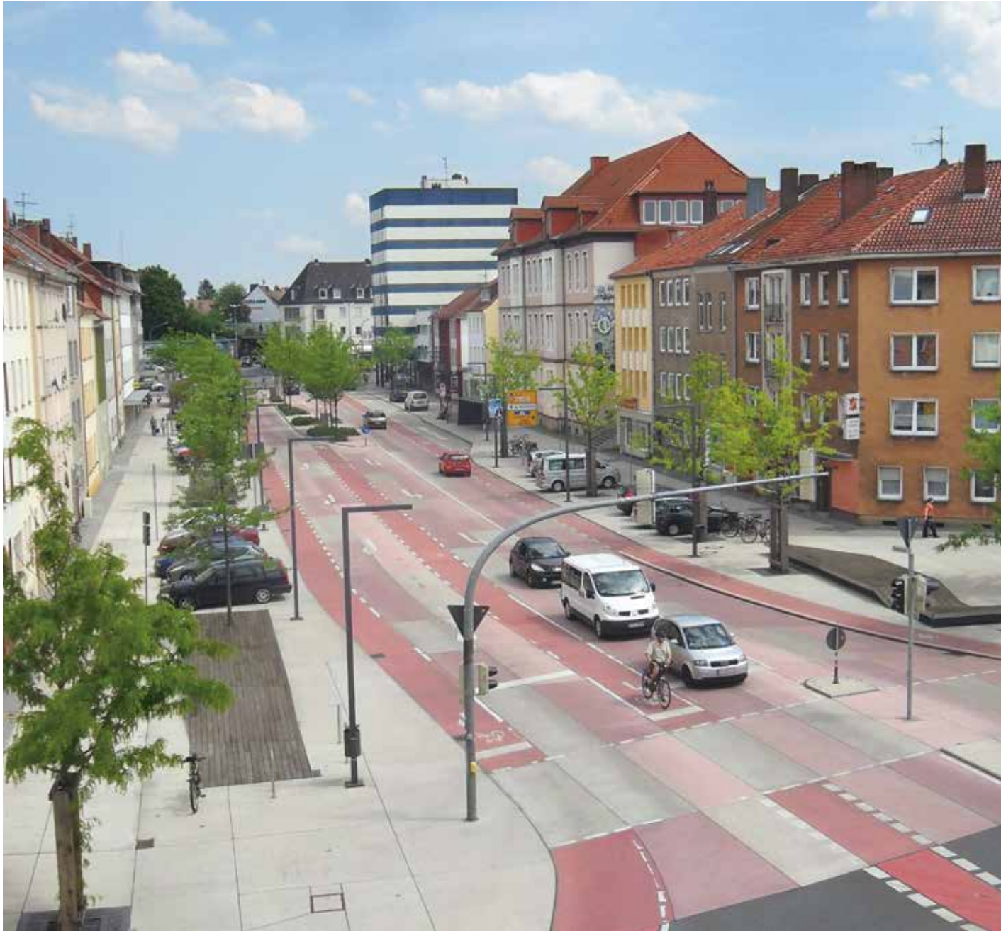
Abb. 16 Der Rosenplatz ist immer noch eine vielbefahrene Straße: aber nun eine, die nicht nur dem Durchgangsverkehr dient, sondern auch die Bewohner, die Fußgänger und Radfahrer respektiert
