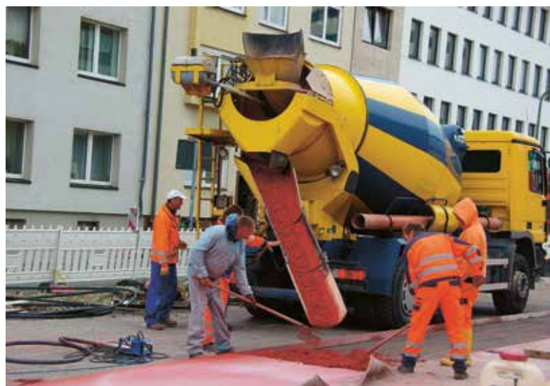
Abb. 7 Einbau des eingefärbten Oberbetons
