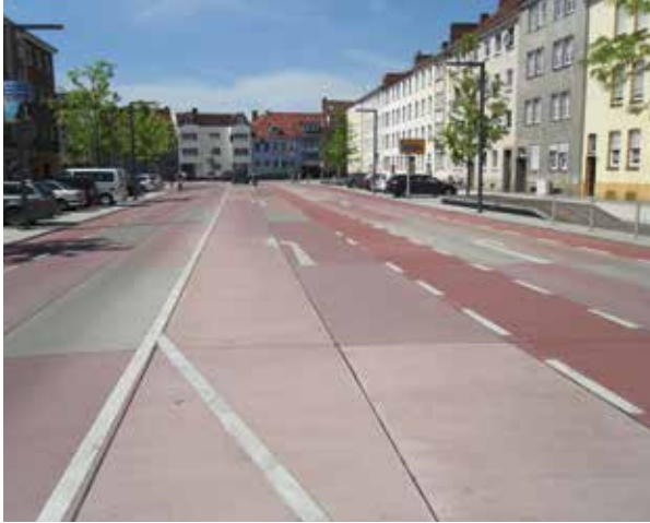
Abb. 9 Felder- und Fugenanordnung Rosenplatz
