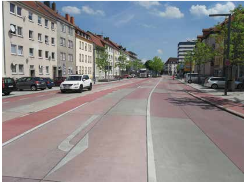
Abb. 14 Die durchpigmentierte Betonschicht sorgt dafür, dass die Farbgebung trotz Verkehrsbelastung erhalten bleibt
