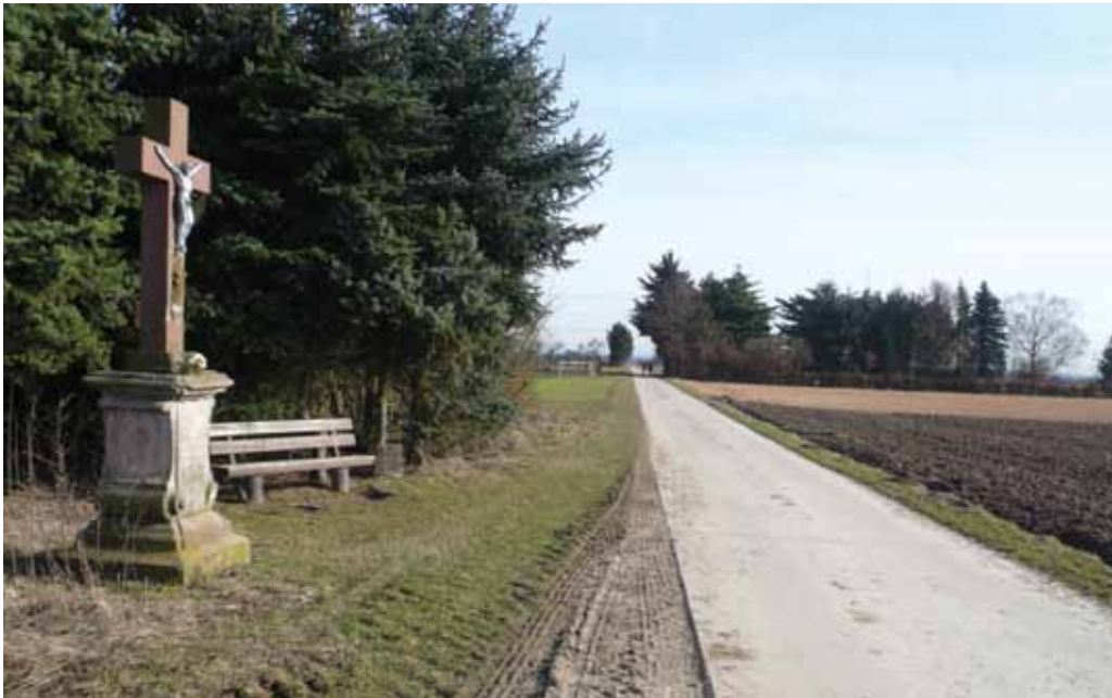
2 Über 50 Jahre alter Betonweg
