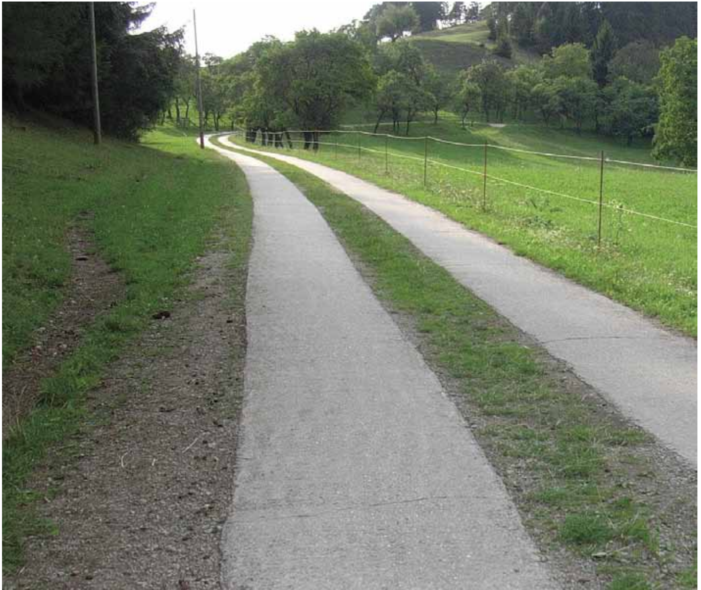
13 Gut erhaltender Betonweg
