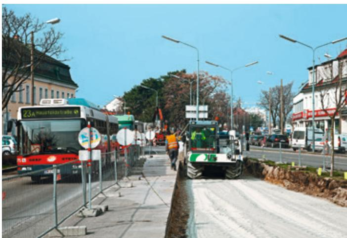
Abb. 9 Bauabschnitt 1: Zementstabilisierung im Bereich Kagraner Platz
