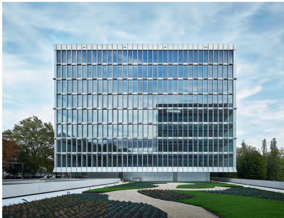
Fig. 1 Vue extérieure du bâtiment. Exterior view of the building. (© Damian Poffet)
