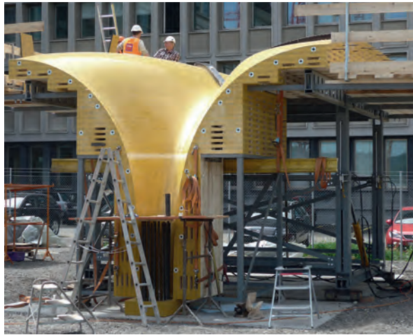
Fig. 6 Aufbau der Schalung. Erection of the formwork.
