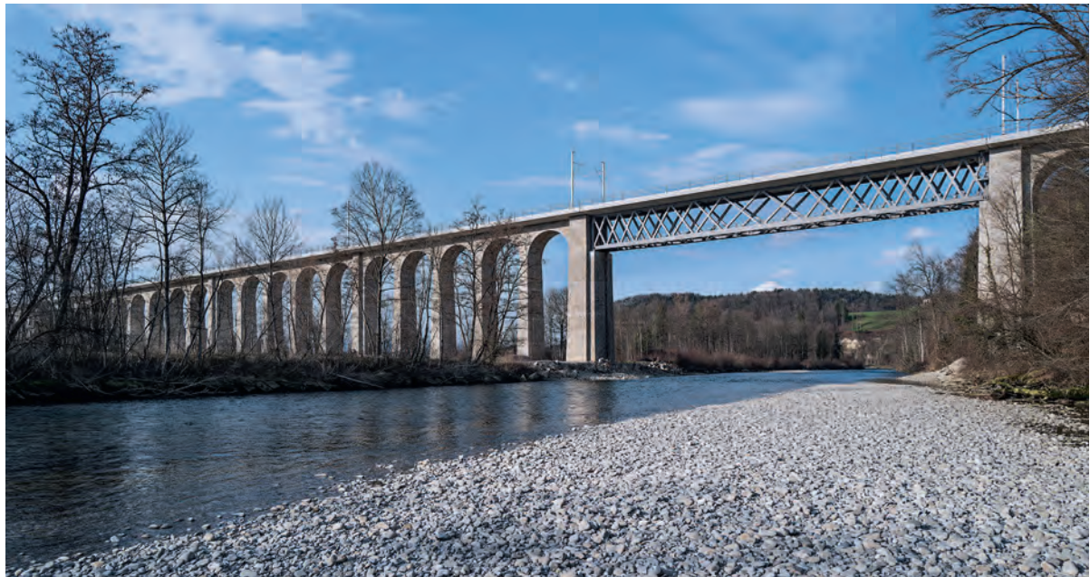
Fig. 1 Das instandgesetzte Saaneviadukt. The refurbished Saane viaduct.
