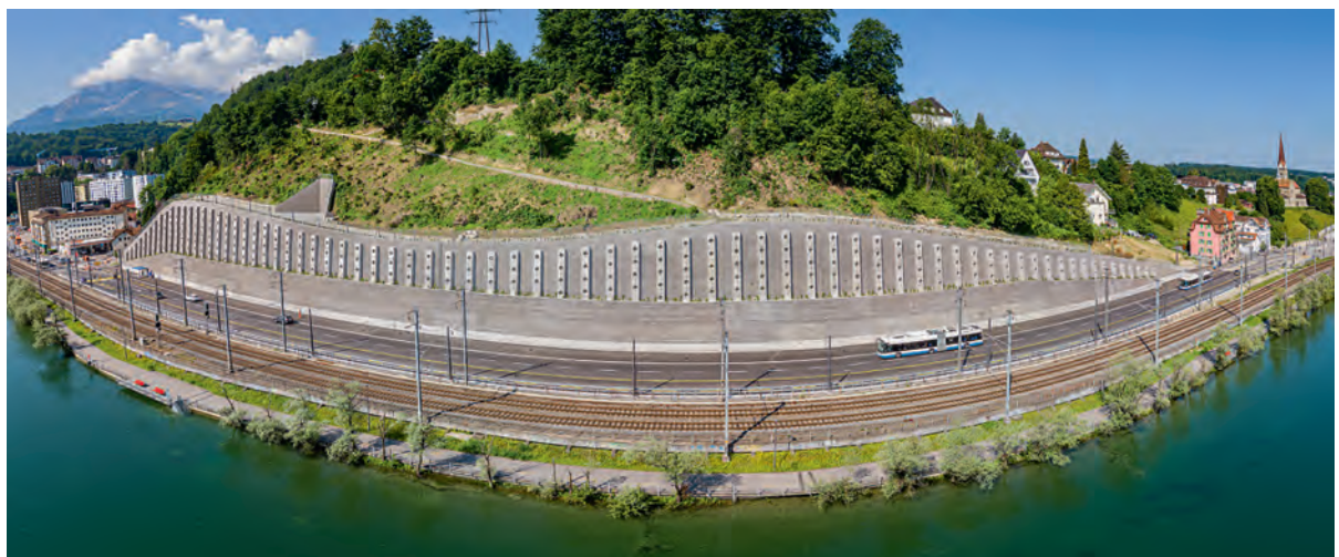
Fig. 1 Gesamtansicht Stützmauer Reussthal. General view of the Reussthal retaining wall. (© Emch+Berger WSB AG)
