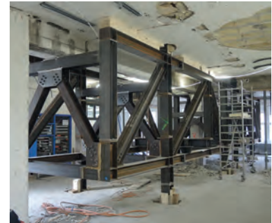
Fig. 8 Doppeltes Stahlfachwerk, das die Funktion des Reaktionsrahmens übernimmt. Double steel truss serving as reaction frame.
