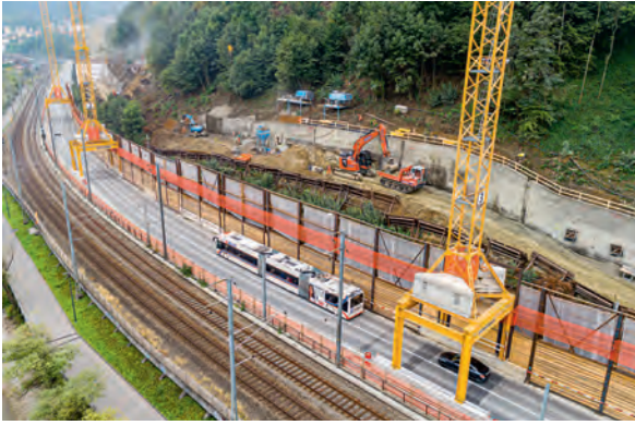
Fig. 5 Aushub und temporäre Sicherung; Linienbaustelle hinter dem Schutzgerüst. Excavation and temporary anchoring; line construction site behind the protective scaffolding. (© Emch+Berger WSB AG)
