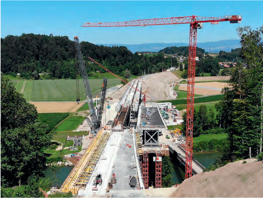
Fig. 6 Baustelle während dem Betriebsunterbruch. Construction site during the interruption of operations.
