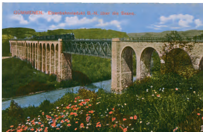
Fig. 2 Saaneviadukt nach seiner Inbetriebnahme. Saane viaduct after its initial operation.
