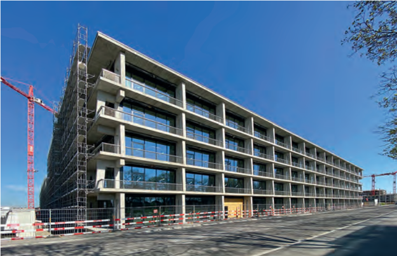
Fig. 2 Erster Blick auf GRID nach dem Abbau des Gerüsts. First view of GRID after dismantling the scaffolding.
