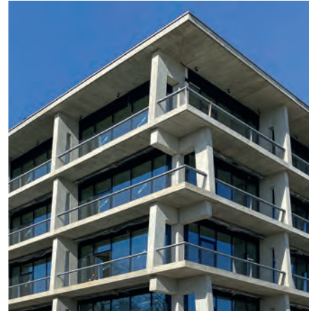
Fig. 8 Gebäudeecke mit versetzten Fassadenschotten. Building corner with staggered façade partitions.
