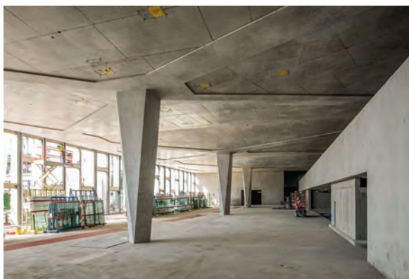
Fig. 5 Intérieur du bâtiment, chantier (atrium, grille de poutres, salle de conférence, dalle de restaurant). Inside of the building, building site (atrium, grid beams, conference room, restaurant slab). (© Maxime Vermeulen)
