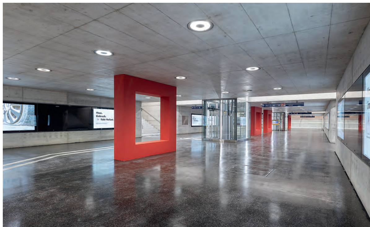
Fig. 1 Neue Personenunterführung, Blick Richtung Vulkanplatz. New pedestrian underpass, view towards Vulkanplatz.
