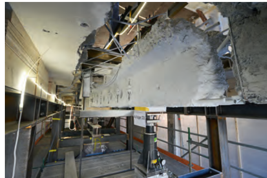
Fig. 10 Vom Gebäude freigeschnittener Stahlbetonunterzug: mit vorgespannten CFK-Schleifen ertüchtigt und mit 15-cm-Bohrungen ausgestattet. Existing floor beam extracted from the building: strengthened with post-tensioned CFRP loops and perforated with 15 cm bore holes.
