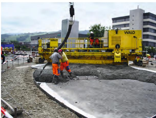
Mise en place à la machine d'un béton pompé sur une chaussée circulaire, Feldstrasse, accès nord à Zoug
