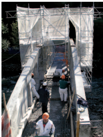
Bétonnage de la couche multifonctionnelle de BFUP (renforcement, étanchéité, revêtement de la dalle de roulement)
