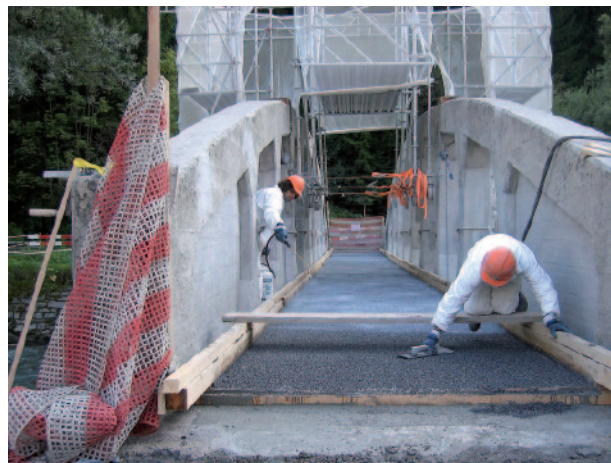
Bétonnage de la couche multifonctionnelle de BFUP (renforcement, étanchéité, revêtement de la dalle de roulement)
