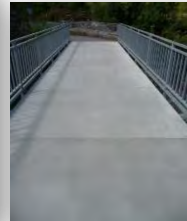
Brücke Linthal, Belag neu mit CPC-Platte
