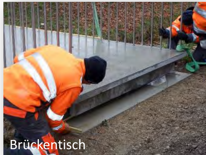
Brücke Chatzenbach mit Carbonverbundträger, Turbenthal, 2018
