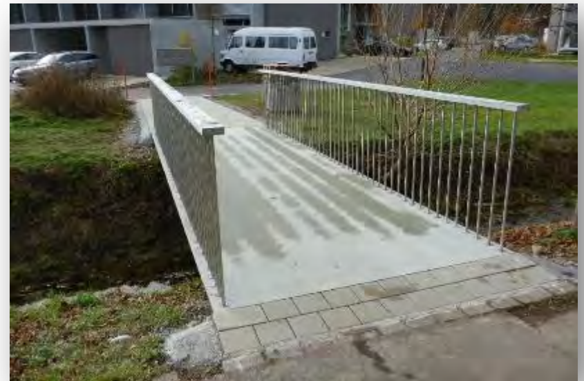
Brücke Chatzenbach mit Carbonverbundträger, Turbenthal, 2018
