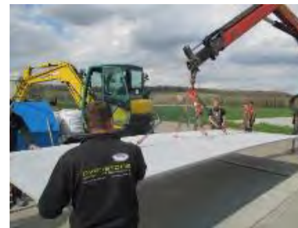
Bauen mit CPC-Schalung/Armierung
