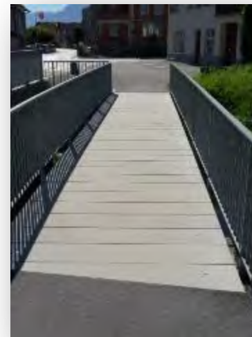
Brücke Tuggen, Belag neu mit CPC-Bohlen
