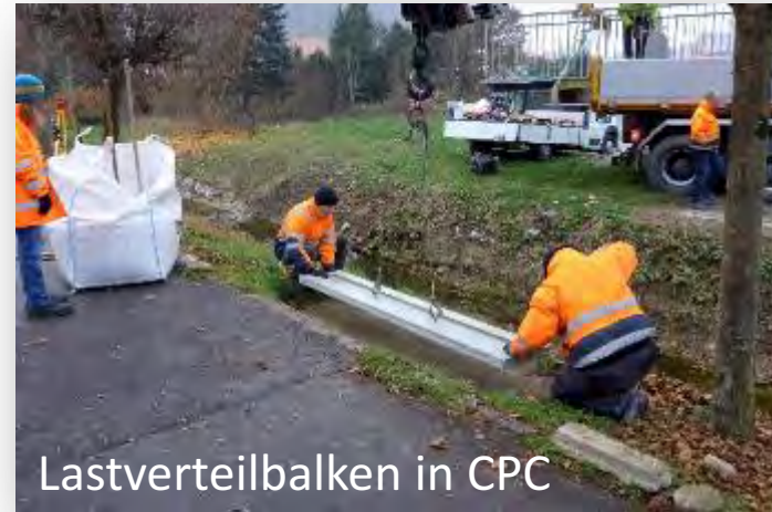
Brücke Chatzenbach mit Carbonverbundträger, Turbenthal, 2018
