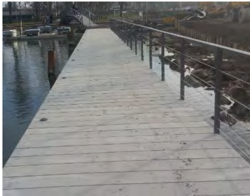
Neuer Steg Unterägeri
