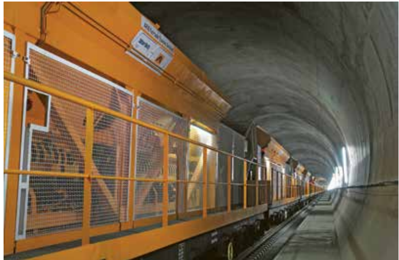
Abbildung 11: Die Zuschlagstoffwaggons des Betonzuges © AFTTG
