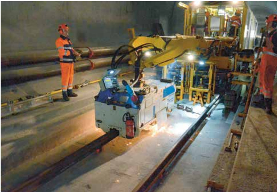
Abbildung 7: Schienenabziehen
