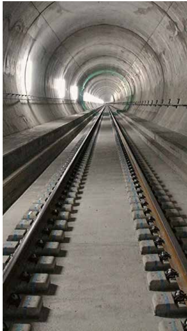
Abbildung 2: Fertiggestellte Feste Fahrbahn in Tunnelabschnitt Faïdo–Bodio West © TTG
