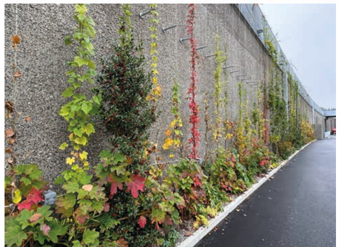
Mauergarten & Aussenwände mit Waschbeton; Bild: Krebs und Herde GmbH, Landschaftsarchitekten BSLA, Winterthur
