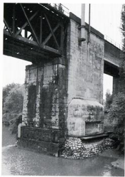
1 Limmatbrücke Zürich-Wipkingen, östlicher Pfeiler
