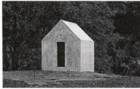
Abb. 107 Conradin Clavuo, Trafostation Vorderprättigau, 1994
