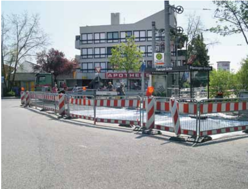
Sécurisation de chantier avec clôture de protection
