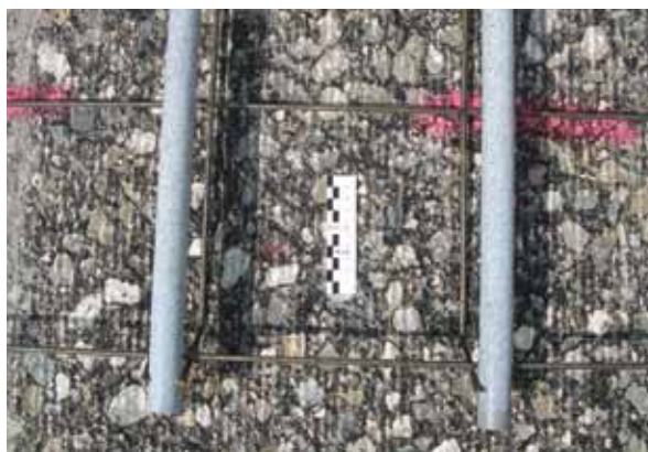
Détail d'une surface fraisée avec goujon sur cage d'armature
