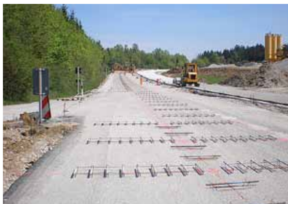
Goujons et ancrés posés sur une surface préparée
