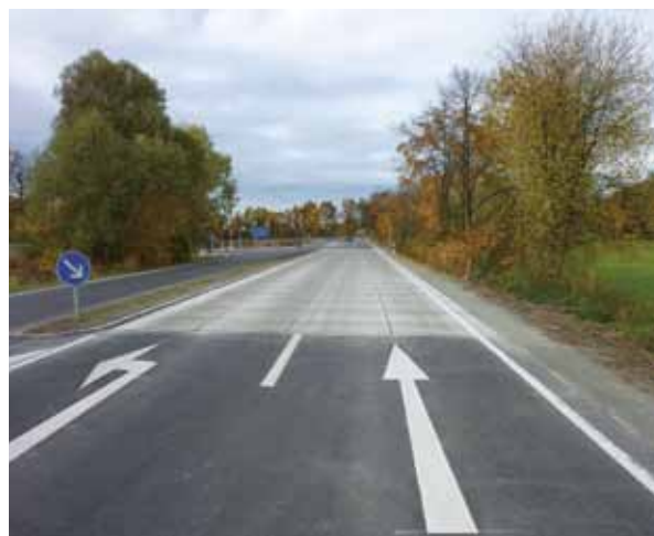
Tronçon de route
