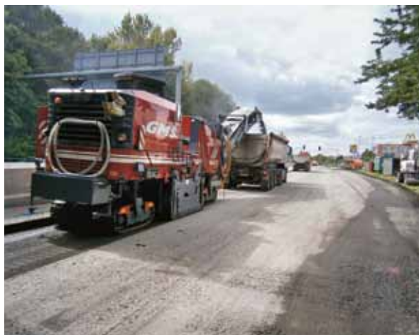
Fraisage d'asphalte
