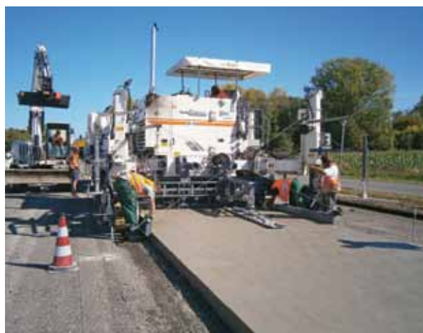
Machine à coffrages glissants
