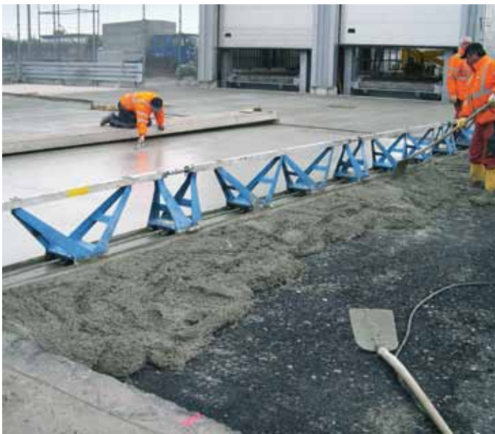
Pose de béton avec règle vibrante
