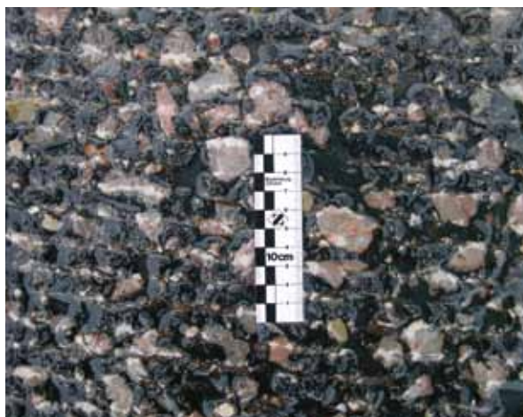
Surface asphaltée fraisée, nettoyée
