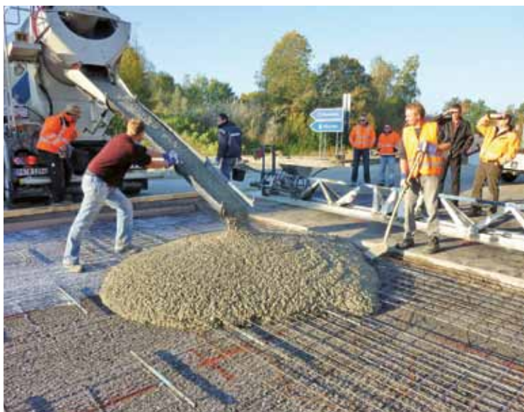
Pose manuelle avec règle vibrante
