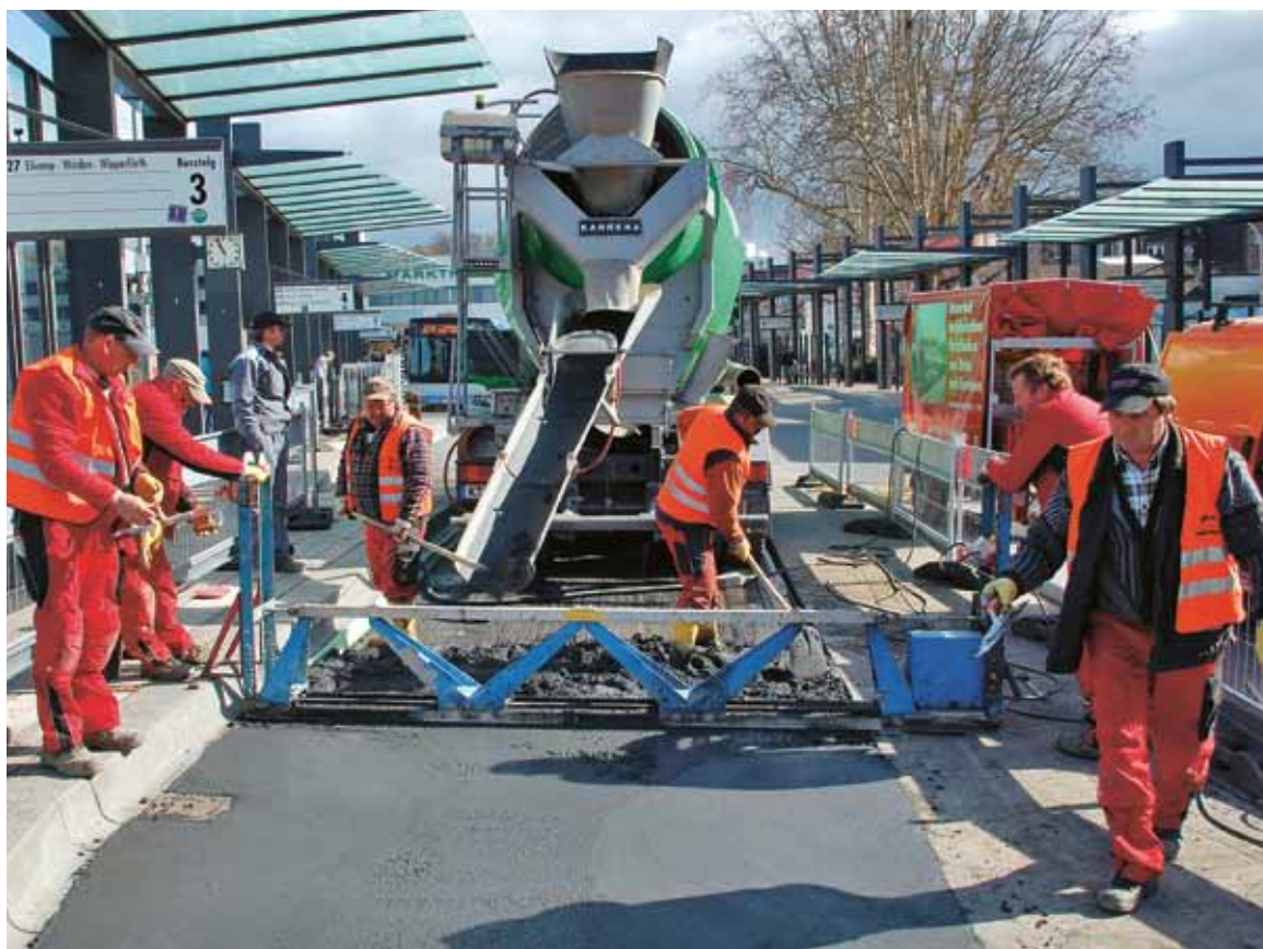
Coulage manuel avec aiguille vibrante et règle vibrante
