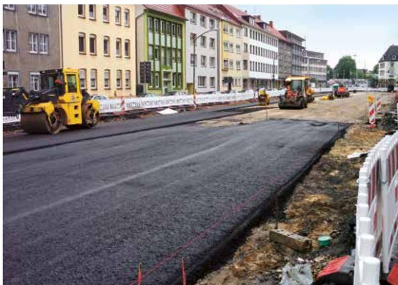
Fig. 5 : Couche d'asphalte
