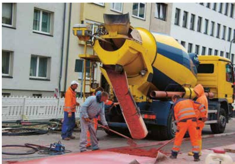
Fig. 7 : Mise en place du béton supérieur teinté dans la masse
