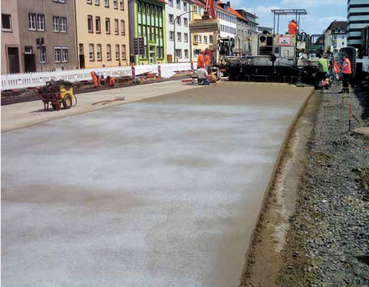
Fig. 6 : Finisseuse en action pour le béton inférieur
