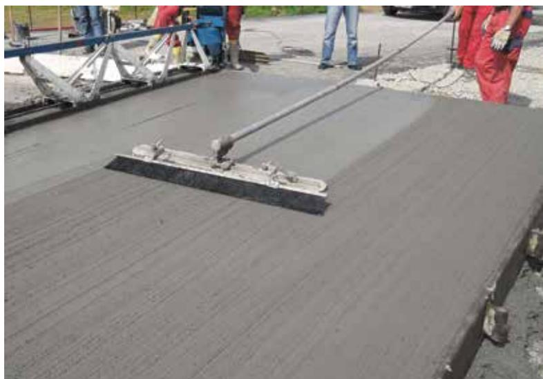
Fig. 8 : Texturation du béton supérieur au balai
