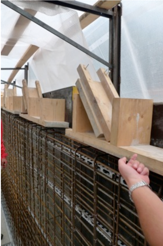
Baustellenprozess – Konterschaltung
