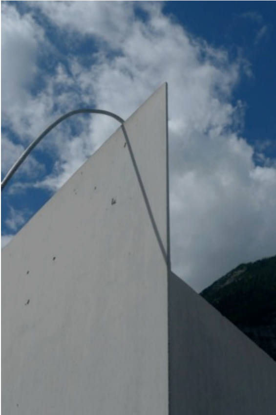
Baustellenprozess – Arbeitsfuge in Gehrung
