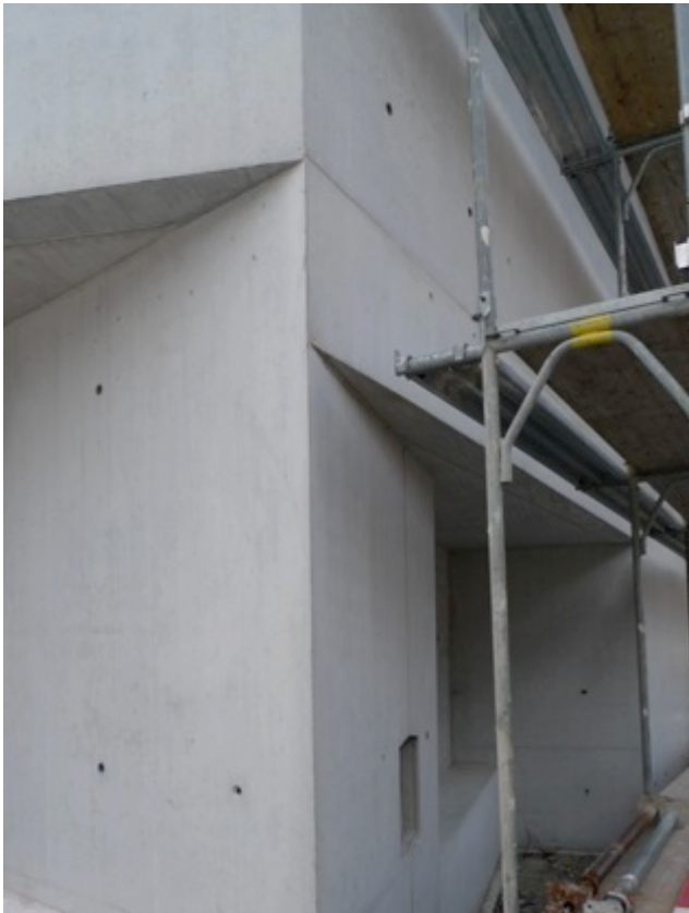
Baustellenprozess – Arbeitsfuge in Gehrung
