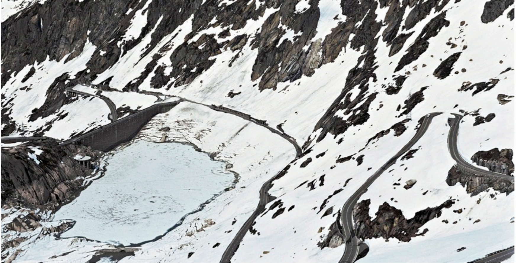
Grimsel – Infrastrukturbauten Passstrasse & Staumauer, Fotografie Christian Helmle
