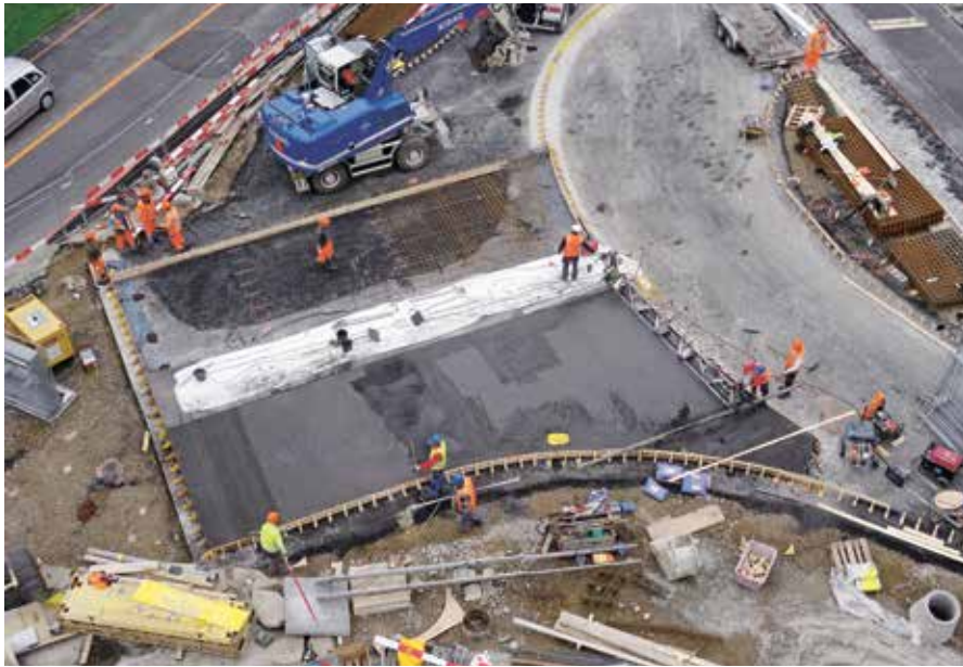
Arbeiten an der ersten Etappe (oben) und an der dritten Etappe (rechts).
