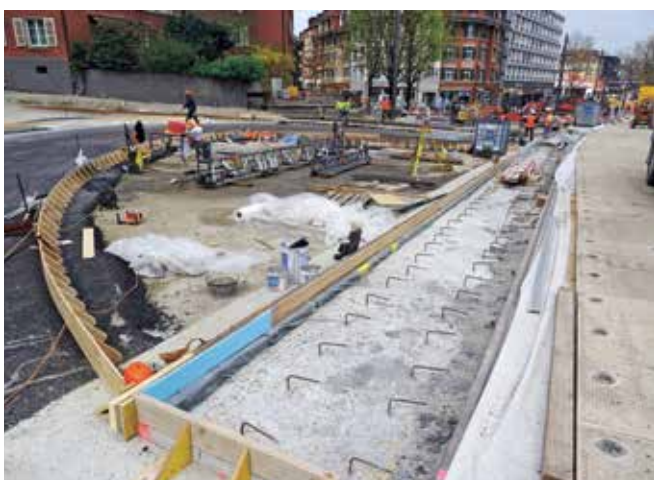
Betonieren der Randstreifen des Gleisbaus im Verbund.
