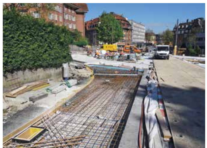
Betonierarbeiten der dritten Etappe.
