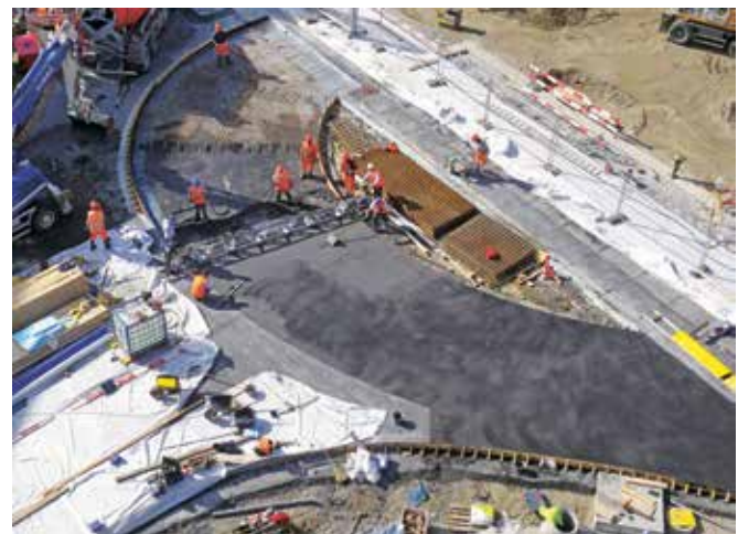
Abziehen der Oberfläche mit dem Vibrationsbalken.
