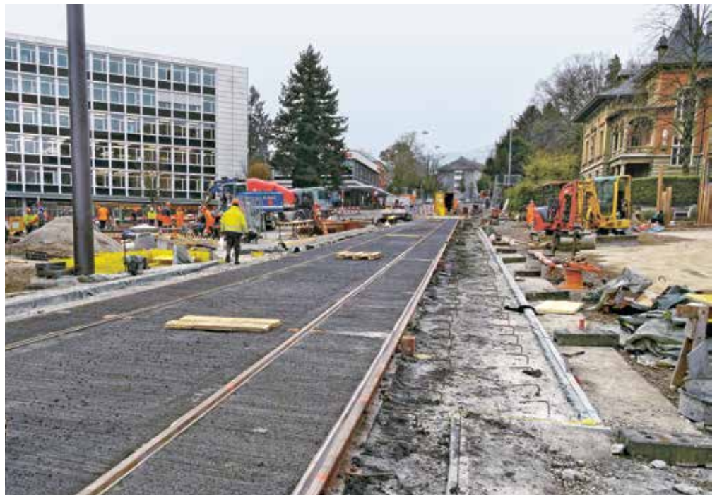
Fertige Tramtrasse vor dem Betonieren des Betonkreisels.
