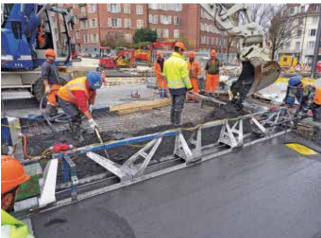
Einbringen des Betons der zweiten Etappe.
