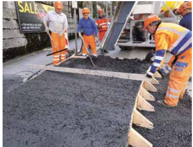
Einbringen des schwarz eingefärbten Betons.
