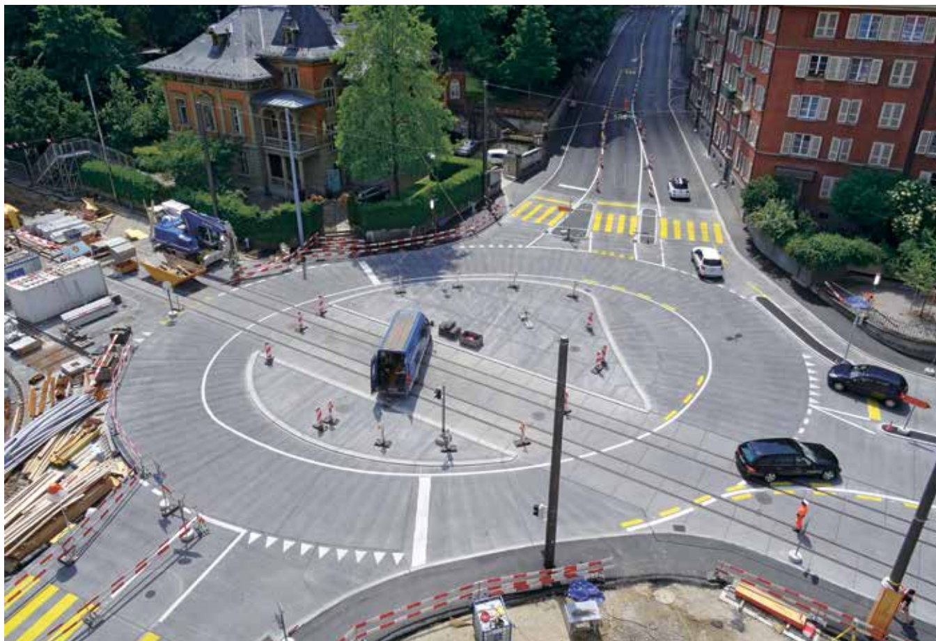
Fertigstellungs- und Fugarbeiten am neuen Betonkreisel.
