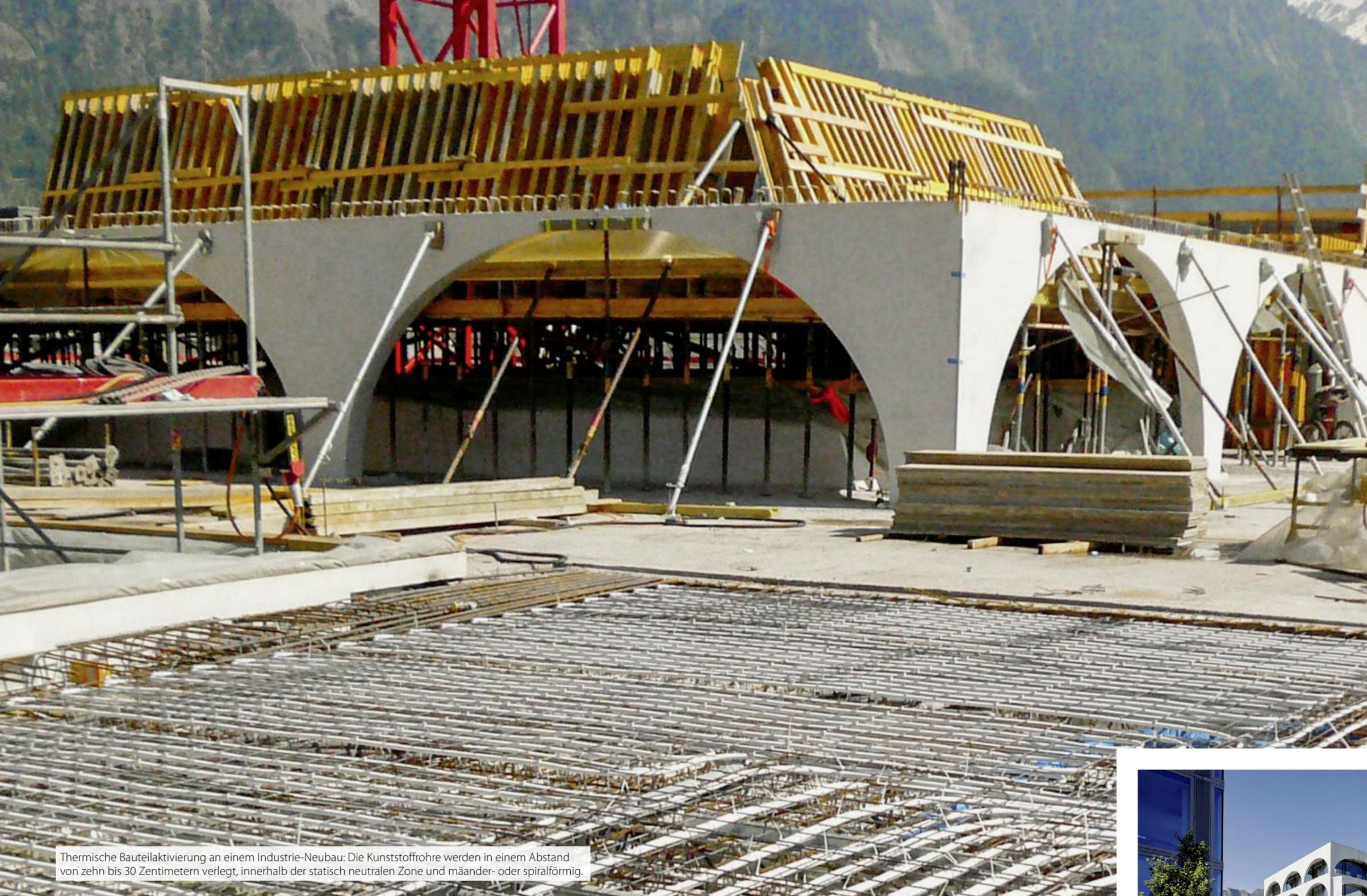
Thermische Bauteilaktivierung an einem Industrie-Neubau: Die Kunststoffrohre werden in einem Abstand von zehn bis 30 Zentimetern verlegt, innerhalb der statisch neutralen Zone und mäander- oder spiralförmig.
