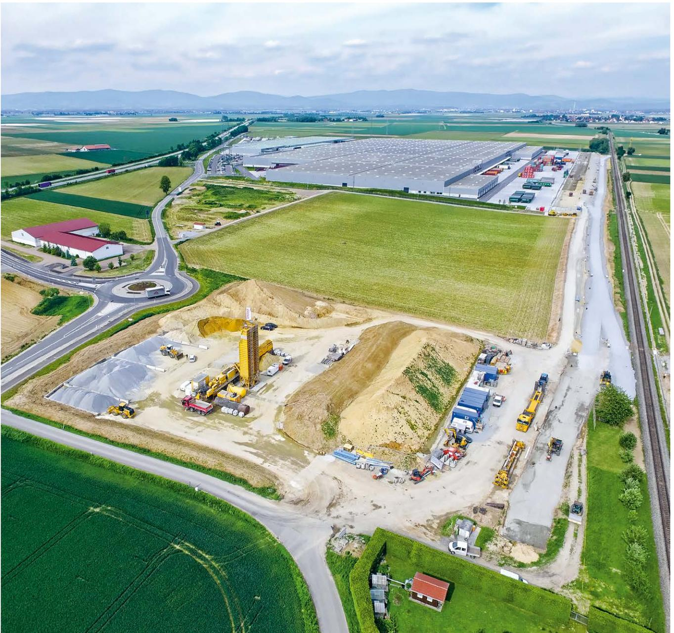
Chantier du centre logistique de BMW à Wallersdorf avec une centrale à béton au premier plan et une zone de construction en arrière-plan
