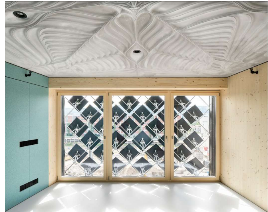
NEST, Dübendorf; Filigrane Deckenelementstruktur
