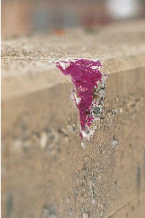
Karbonatisierungstest bei Beton
