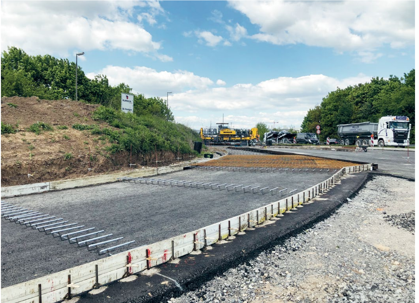
Vorbereitung Betonage mit bewehrtem, geometrisch kritischem Feld; Vorlegen der Dübel in Körben unterhalb der späteren Querschnittsfuge
