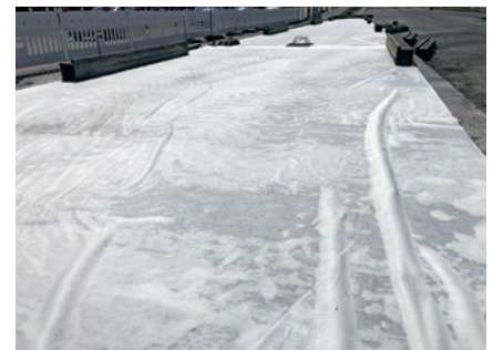
Zusätzliche Nachbehandlung mit wasserhaltendem Vlies
