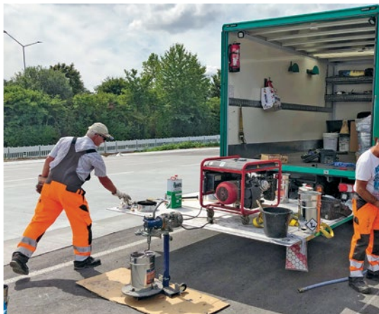
Fugenverguss: Herstellen der zweikomponentigen Kaltfugen- vergussmasse auf Polysulfid- basis
