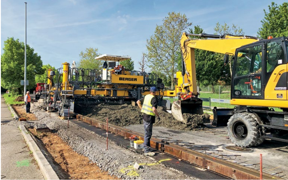
Das erste «Anfahren» unter Produktion des Straßenbaufertigers ist immer spannend und wurde mit Bravour vom Bedienungs- und Einbaupersonal gemeistert.
