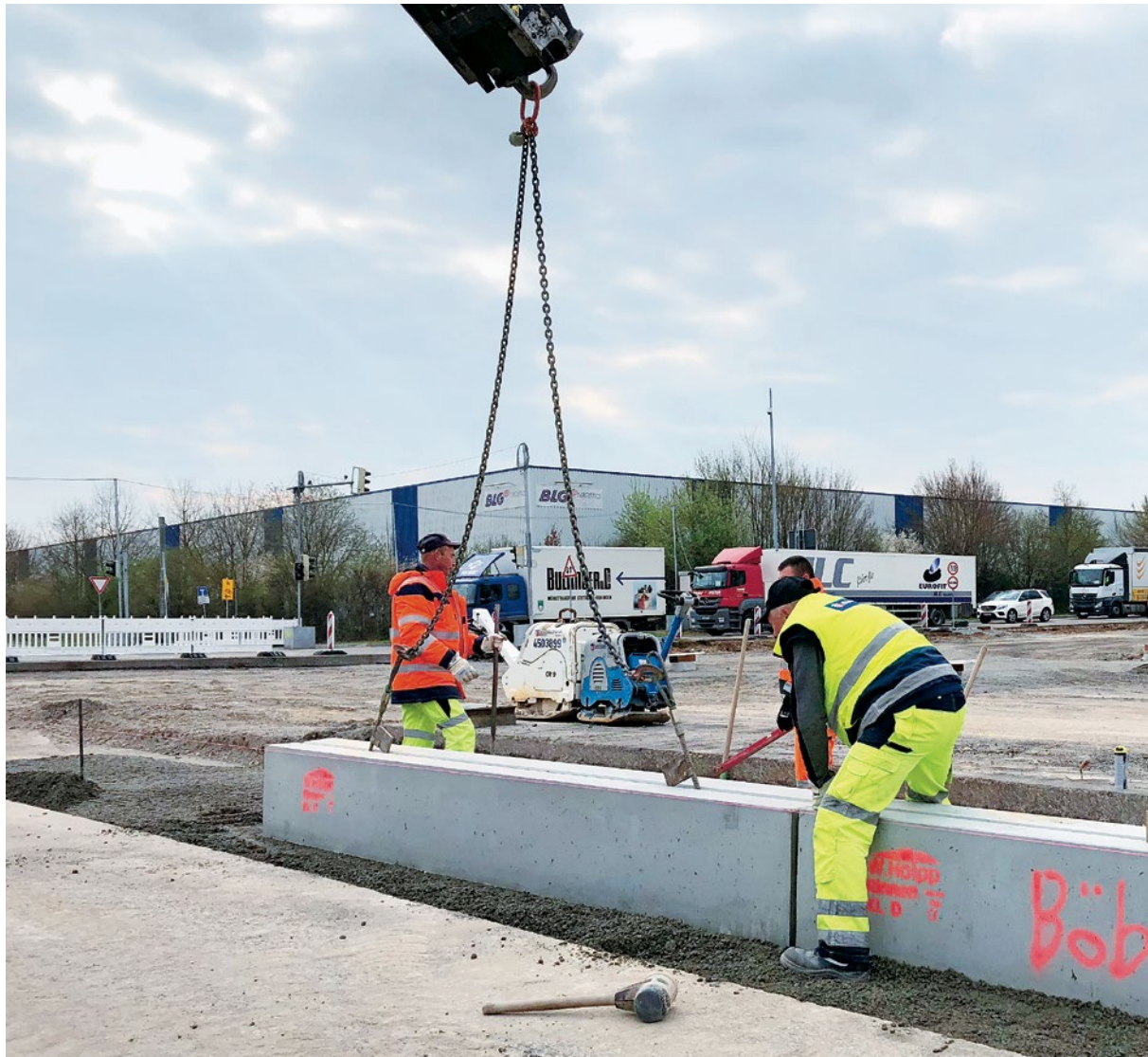
Tiefbauarbeiten, neue leistungsfähigere Straßenentwässerung
