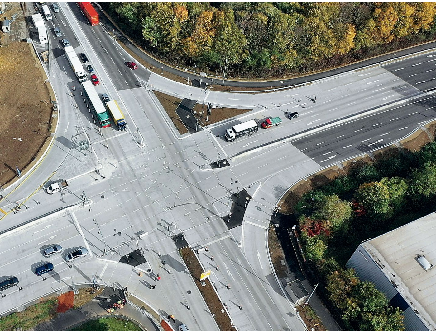
Luftaufnahme des fertiggestellten Daimler-Knotens
