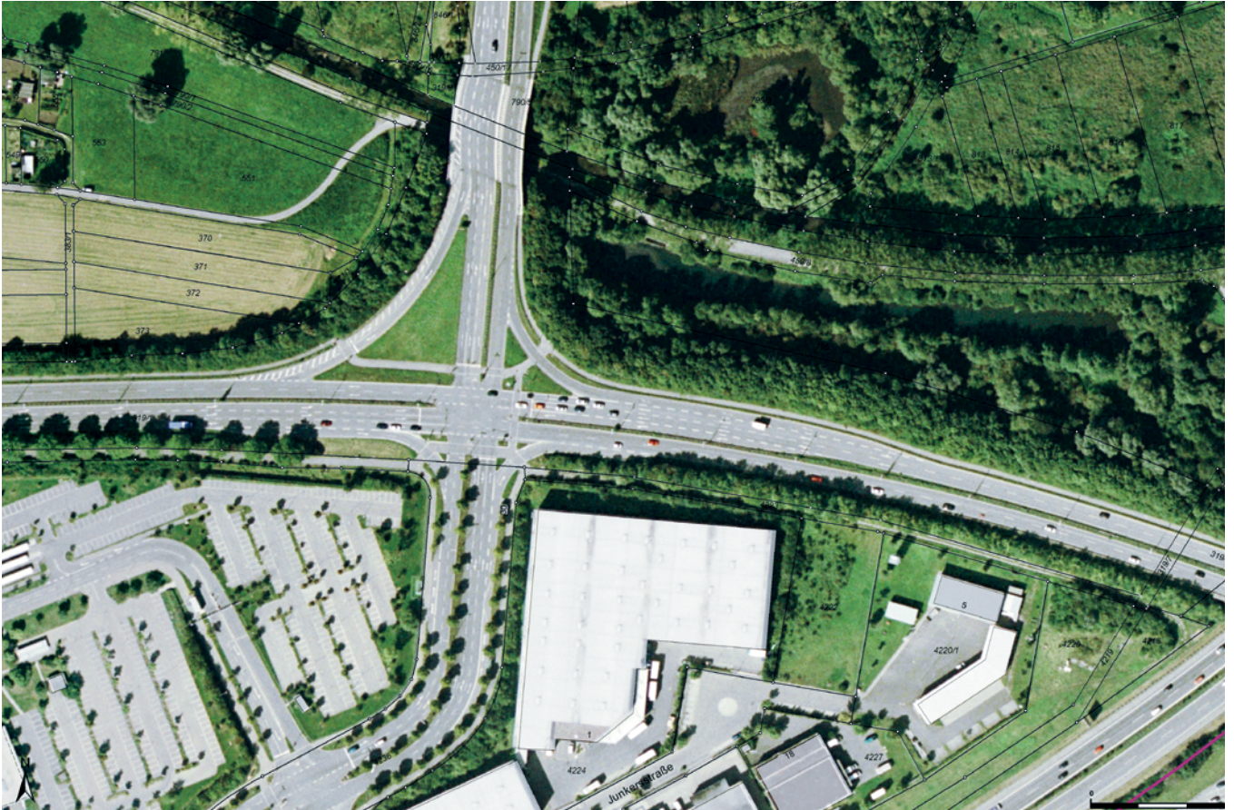
Daimler-Kreuzung vor dem Umbau
