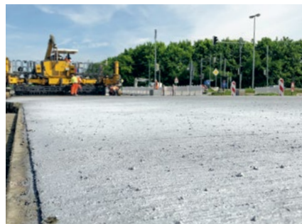
Aufgespritztes weiß eingefärbtes Curing zur Nachbehandlung
