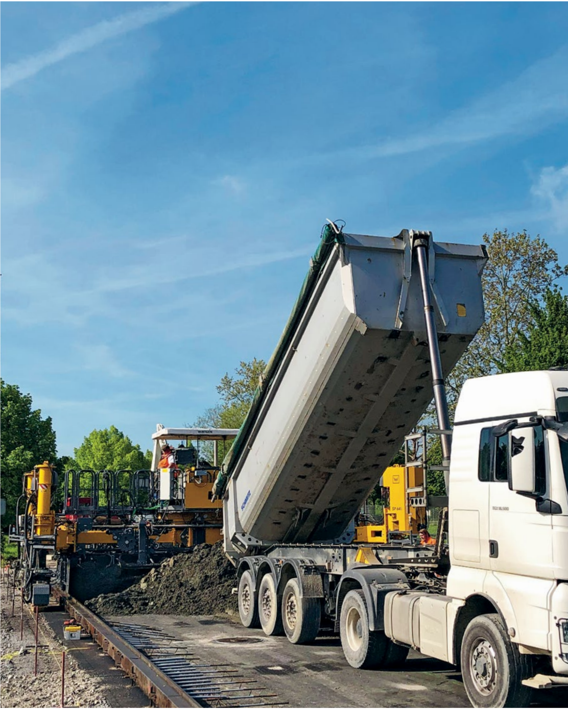
Betoneinbau mit Beton-Straßenfertiger in der Konsistenzklasse C1
