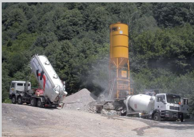
Installations de chantier, bétonnière mobile et dépôt de matériel
