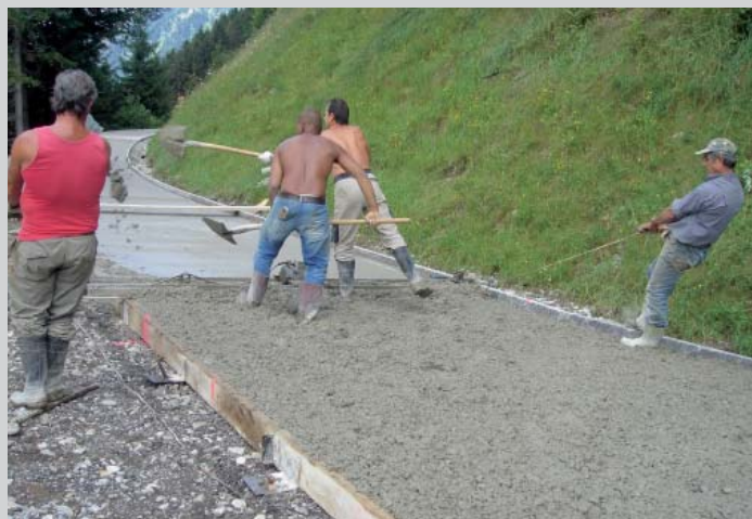
Mise en place du béton: finition à la règle vibrante
