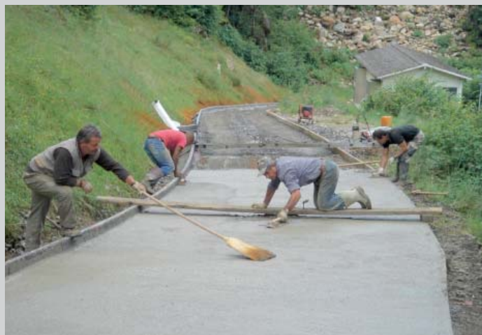
Travaux de cure: lissage à la taloche et surfacage au balai
