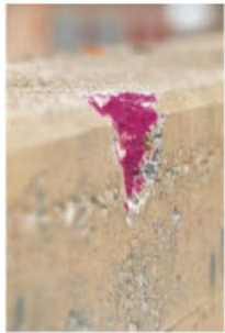
Karbonatisierungstest bei Beton
