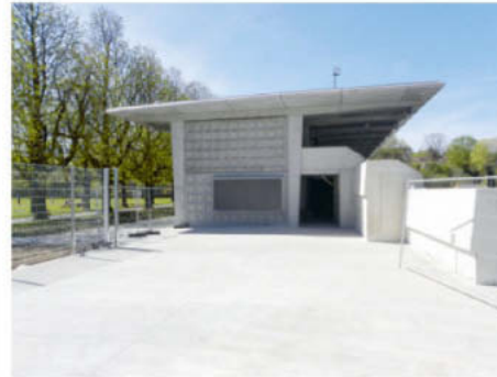
Tribünengebäude St.Jakob, Basel (Projekt von Netwerch)
