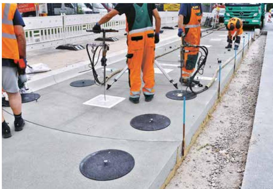
Mise en œuvre de résine silicate après la pose et l'alignement des éléments préfabriqués
