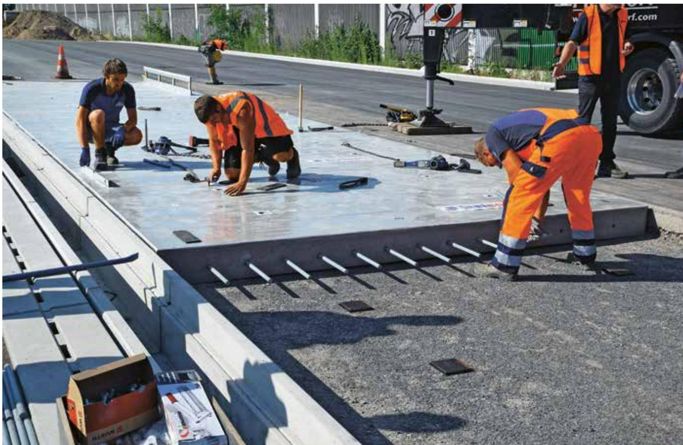
Élément préfabriqué assemblé par goujons (système goujon et évidement)
