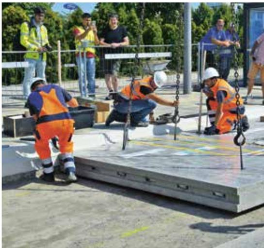
Mise en place de la seconde dalle préfabriquée au niveau du regard par un système de pose classique (câbles en acier et ancrages de levage)
