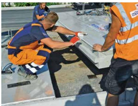
Pose d'un élément préfabriqué par assemblage à tenon et mortaise
