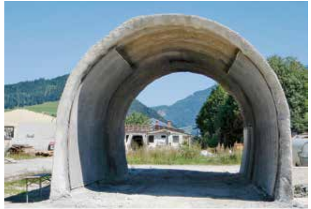
Illustration 2 : tunnel d'essai initial (source : VÖZFI)
