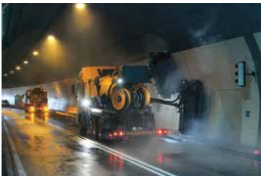
Illustration 1 : mesure des facteurs de luminance à 5 emplacements différents avant et après le lessivage du tunnel (source : SMG)
