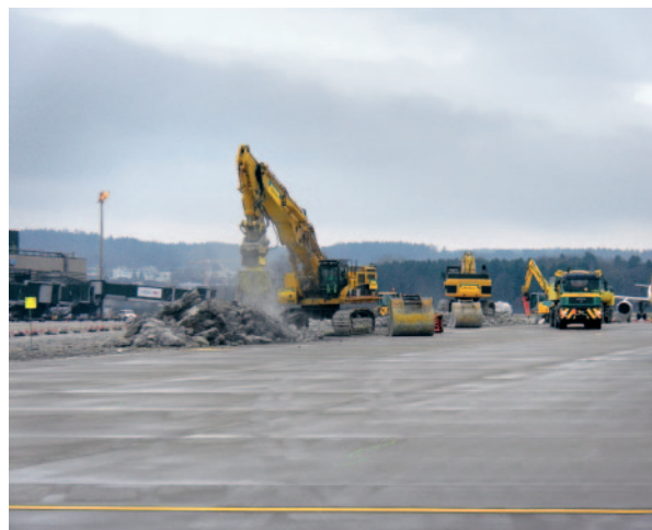
Démolition du béton usagé
