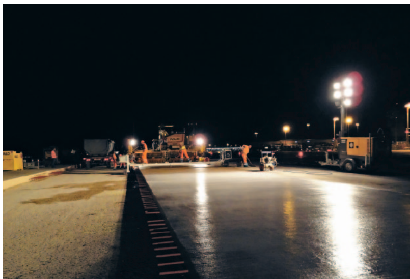
Mise en place mécanique du béton au moyen d'une finisseuse à coffrage glissant
