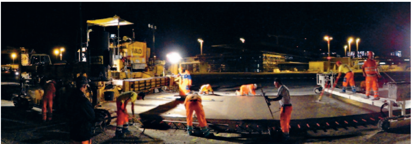
Mise en place mécanique du béton au moyen d'une finisseuse à coffrage glissant
