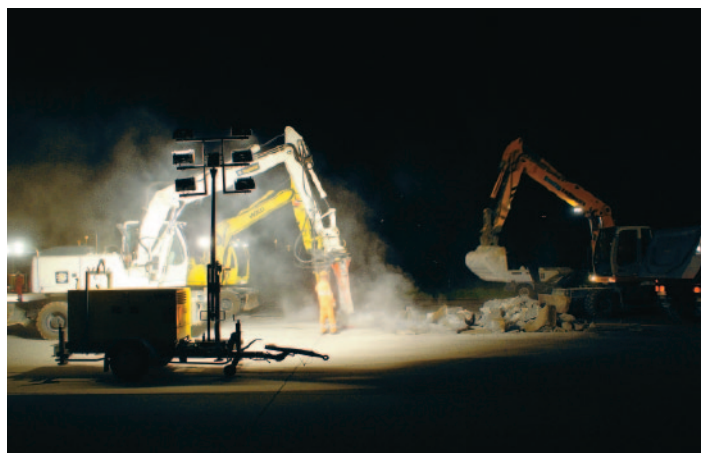
Démolition d'un segment de la piste durant la pause nocturne
