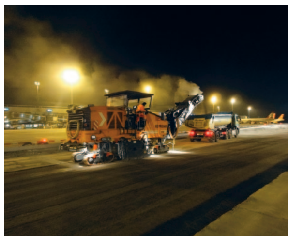
Fraisage de la couche de fondation stabilisée au ciment
