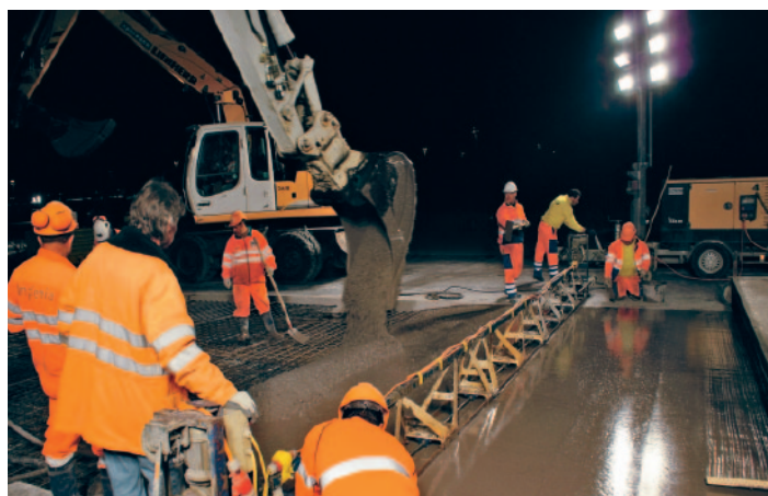
Mise en place du béton à montée en résistance rapide (résistance à la compression après 2,5 heures : 20 N/mm 2 )
